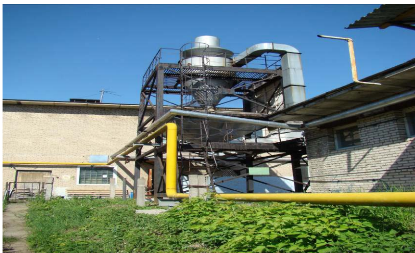
Пылеулавливающая установка от деревообрабатывающих станков
