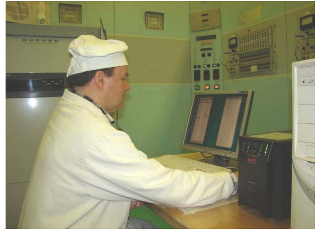
Центральный дозиметрический пульт системы радиационного контроля
