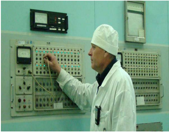
Центральный дозиметрический пульт системы радиационного контроля
