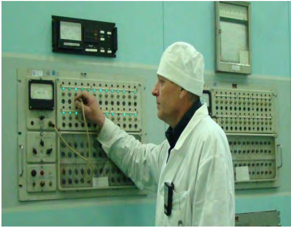
Центральный дозиметрический пульт системы радиационного контроля.
