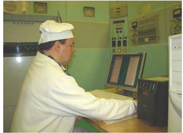
Центральный дозиметрический пульт системы радиационного контроля.
